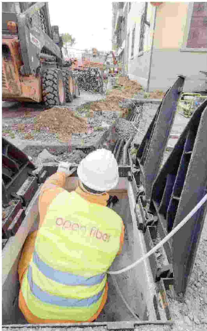
Lavori di scavo per la posa della fibra ottica
